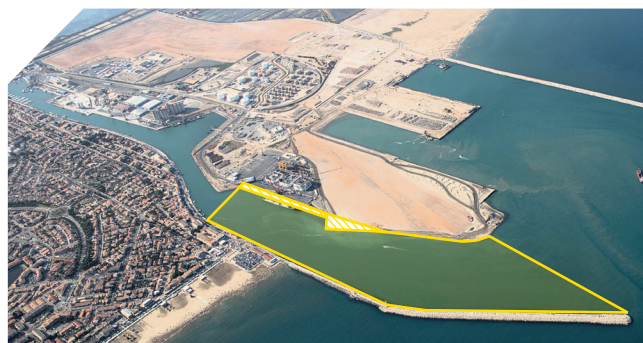
Travaux accès nautiques chenal d'accès sud
