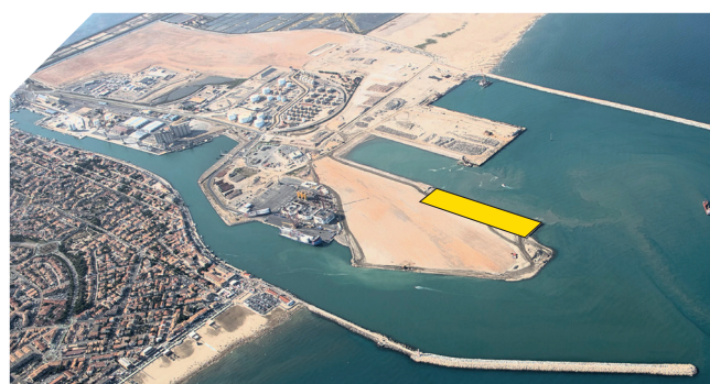
Figure 16 : Mise en place d'un revêtement en béton sur les quais nord
