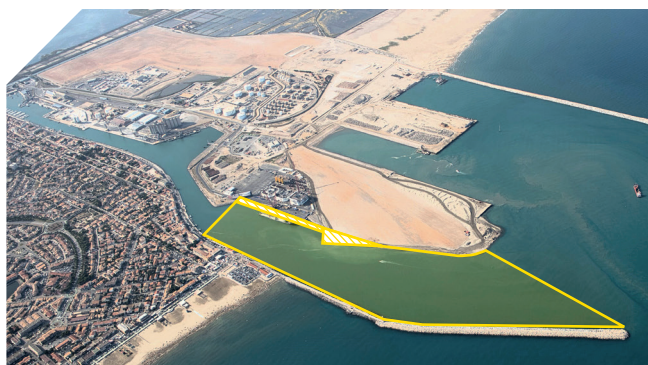
Figure 17 : Travaux accès nautiques chenal d'accès sud
