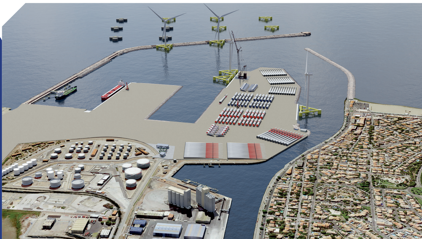
Figure 24 : Le installations NOUVEOL, en phase d'intégration des turbines
