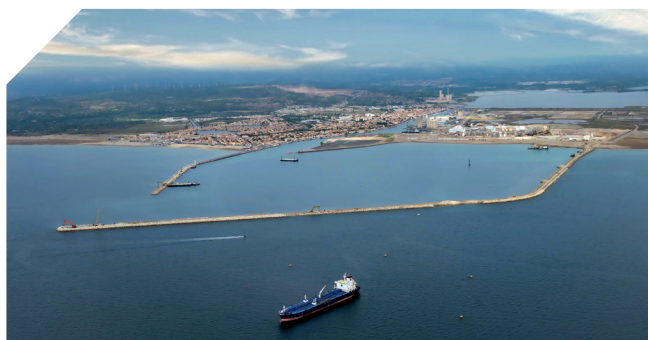
Figure 10 : Construction des digues extérieures – 2022
